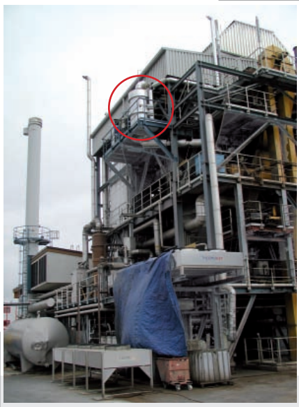
Foto des katalytischen Teerreformers am Biomassekraftwerk in Güssing, Österreich und Detailansicht
