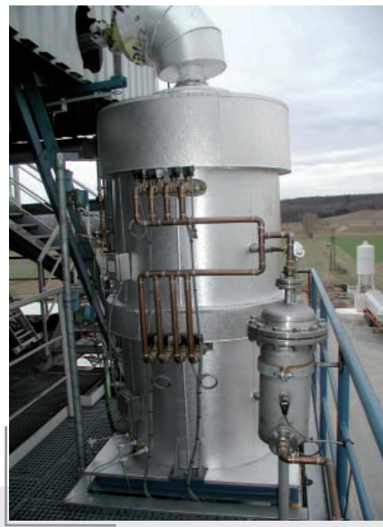
Foto des katalytischen Teerreformers am Biomassekraftwerk in Güssing, Österreich und Detailansicht
